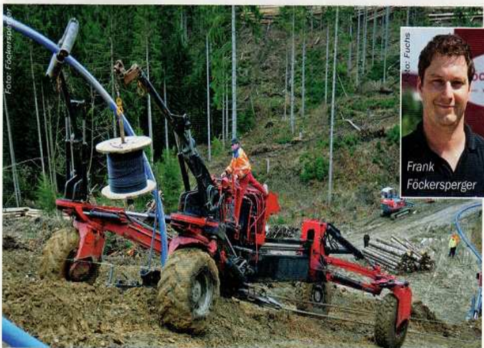
Selbst in schwierigem Gelände kann der Kabelpflug Rohre und Kabel verlegen, ohne dass Gräben aufgerissen werden müssen.
